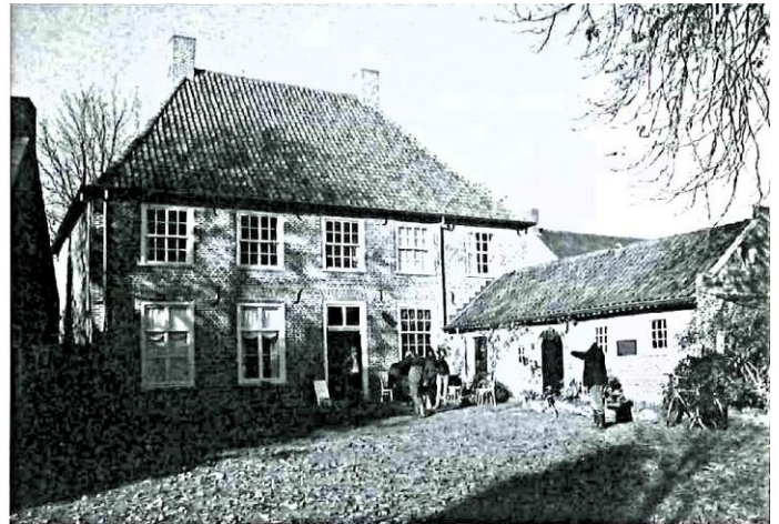
Afb. 3 De achterzijde van de pastorie van de Hervormde Gemeente in Nuenen (Berg 26). Rechts de aanbouw waarin Vincent van Gogh in de maanden december 1883 - mei 1884 zijn atelier had. (Foto: Nico Arts)
